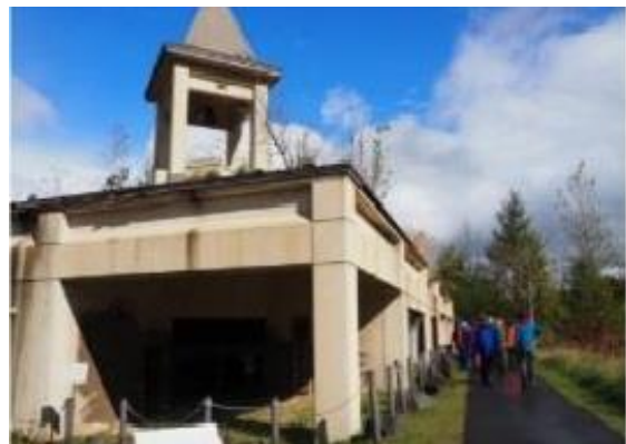
有珠山噴火遺構(泥流入町民浴場)
